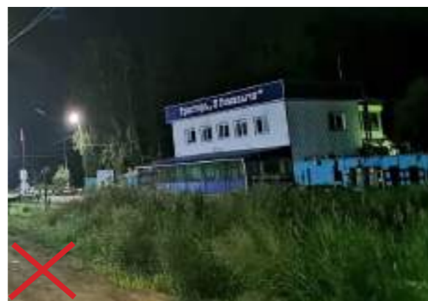
Недопустимо не применять фасадную подсветку главного фасада здания. Освещение должно быть обеспечено в темное время суток в часы работы и в нерабочее время.
