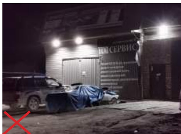
Недопустимо устанавливать светильники (прожекторы) со слепящим эффектом.
